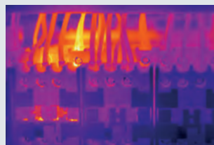
Údržba zařízení: rozpoznání příliš vysokých teplot na pojistkách a elektrických součástkách dřívě, než dojde k výpadkům.
